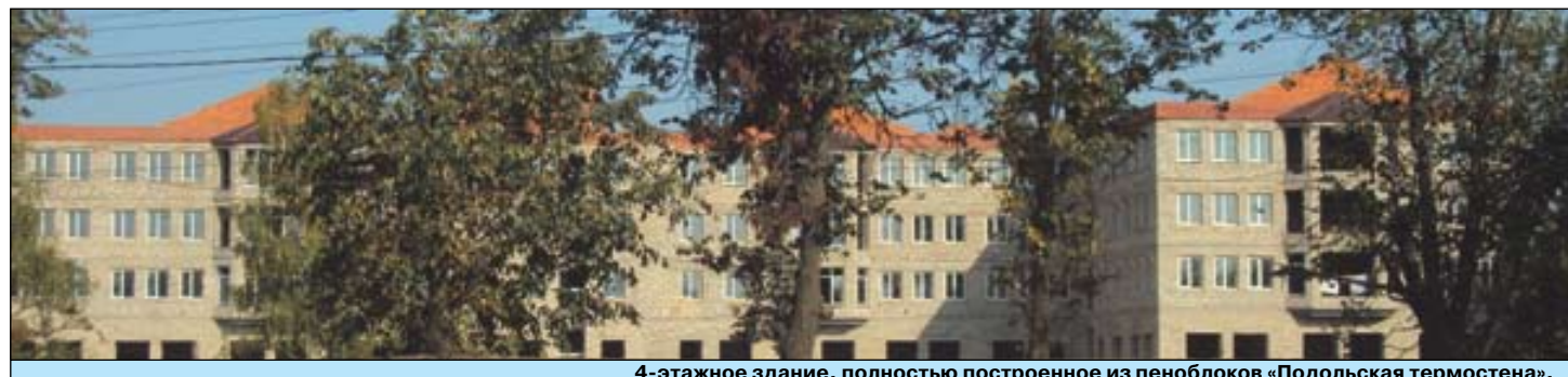
4-этажное здание, полностью построенное из пеноблоков «Подольская термостена».
