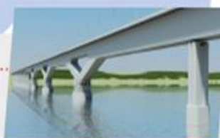
МОСТОВОЙ ПЕРЕХОД ЧЕРЕЗ Р.ВОЛГУ
