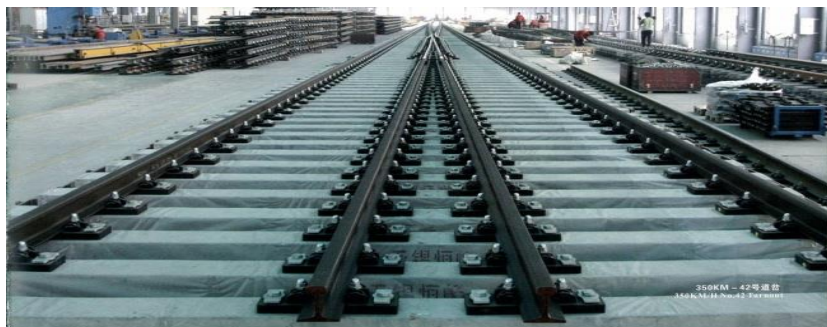
Конструкция безбалластного верхнего строения пути
